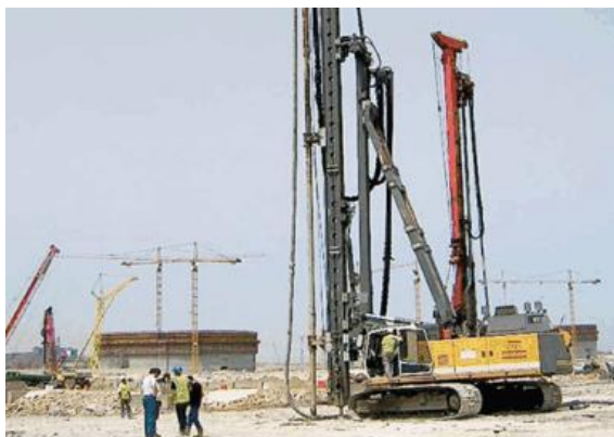
Serviços de Compaction Grouting em andamento em depósito de areia fôfa em área portuária.
