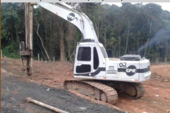
Execução de pré-furo para atravessar a camada de aterro, chegando-se aos depósitos de solo mole.
