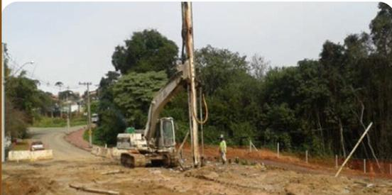
Execução de pré-furos para atravessar a camada de aterro superficial.
