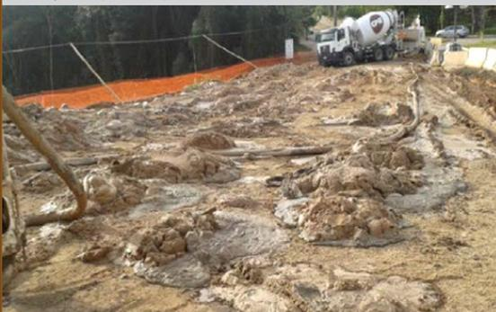
Pelo posicionamento do geogROUT no solo, percebe-se a posição das verticais de bulbos de compressão do solo.
