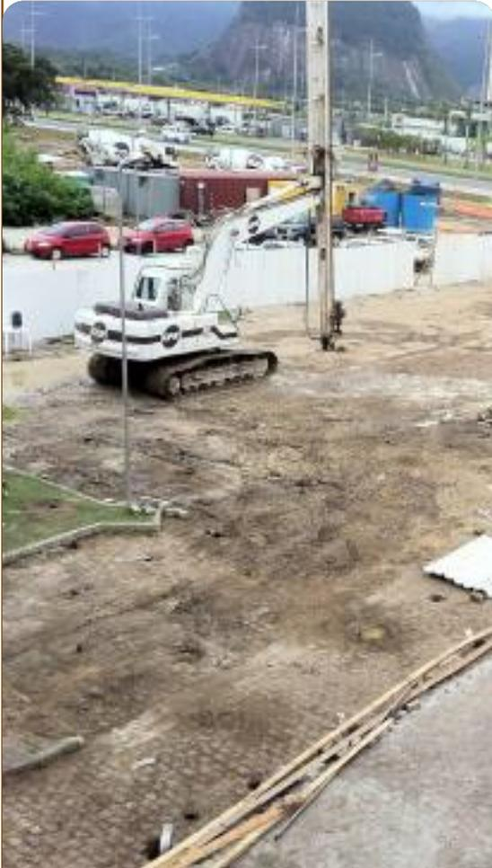
*A geologia em torno do Shopping Station Mall é formada por solo muito mole, eram frequentes as deformações no pavimento (estacionamento). O desenvolvimento dos serviços de melhoramento do solo com CPR Grouting transcorreu sem maiores problemas. As etapas de monitoramento com pressiómetro, com piezômetro e com placas de recalque informaram o melhoramento do solo de fundação de acordo com o padrão desenvolvido em outras obras.*
