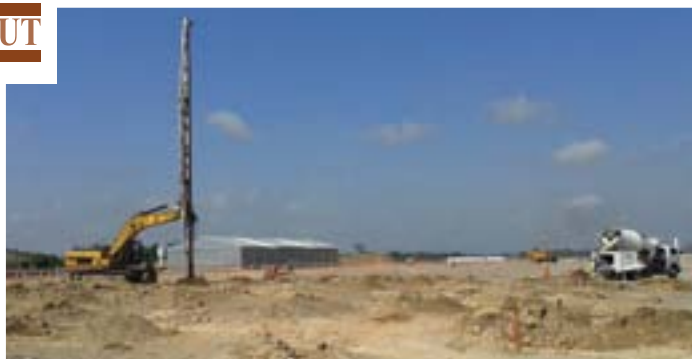
Camadas de areias fofas até 20m de profundidade impediam a construção da fábrica.
