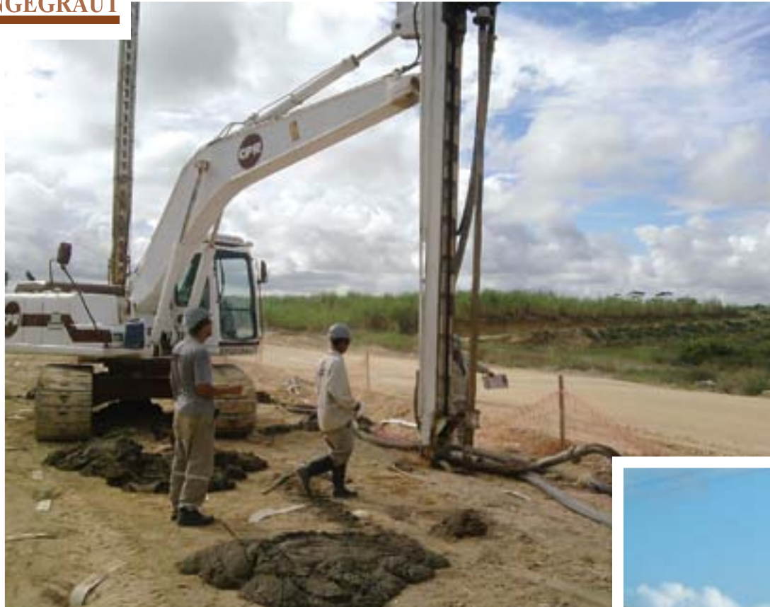
Esta importante rodovia dá acesso à famosa praia de Porto de Galinhas. Acima, a formação dos verticais de enrijecimento entre geodrenos previamente instalados, em meia pista.
