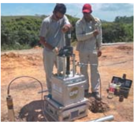
Monitoramento com ensaios pressiométricos antes e após o CPR Grouting.
