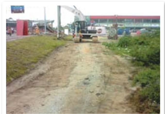
Os serviços de cravação de geodrenos.
