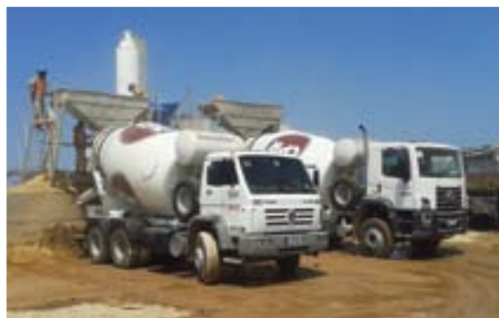
A central do geogROUT na obra.
