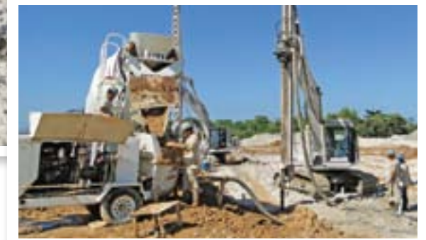
Geodrenos e verticais de enrijecimento do solo de fundação sendo executados, imediatamente seguido pelo aterro.
