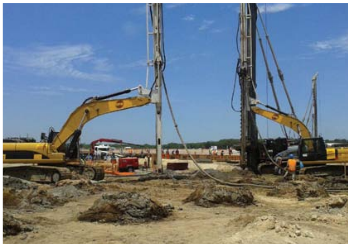
Execução de verticais de enrijecimento ao longo de 20m de profundidade, em um depósito de areias fofas, com monitoramento do nível de resistência e rigidez praticamente simultâneo aos serviços.
