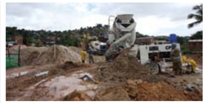
O importante canal do Rio da Prata, no bairro do Ibura, em Recife, PE, só se tornou viável com CPR Grouting. Um espesso depósito de solo mole com 25m de profundidade foi enrijecido, para receber o canal pré moldado.
