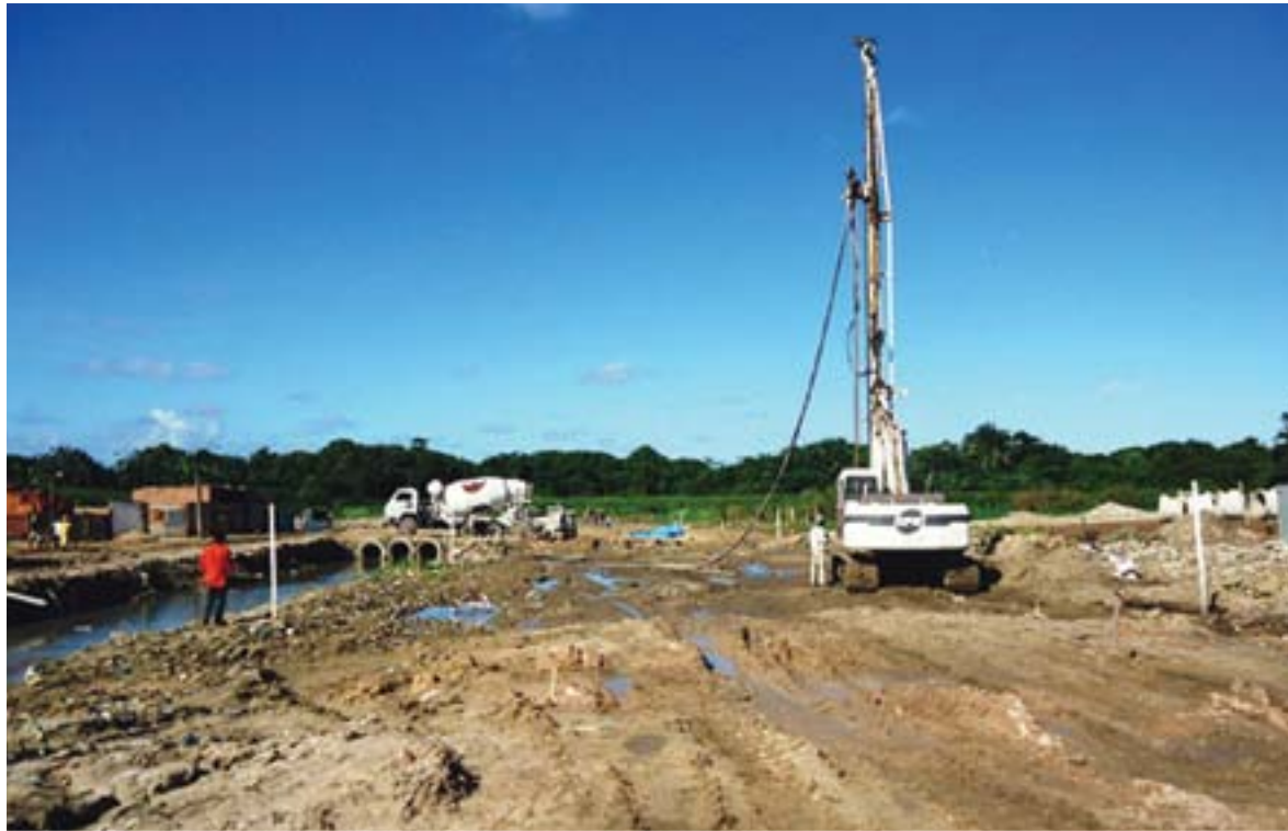
O serviço de cravação de geodrenos e execução de verticais de enrijecimento ao lado do antigo canal em sua situação original.
