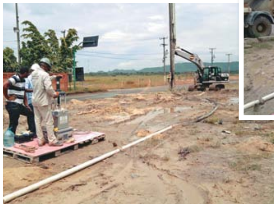
Análises pressiométricas para certificação da melhoria do solo com CPR Grouting.
