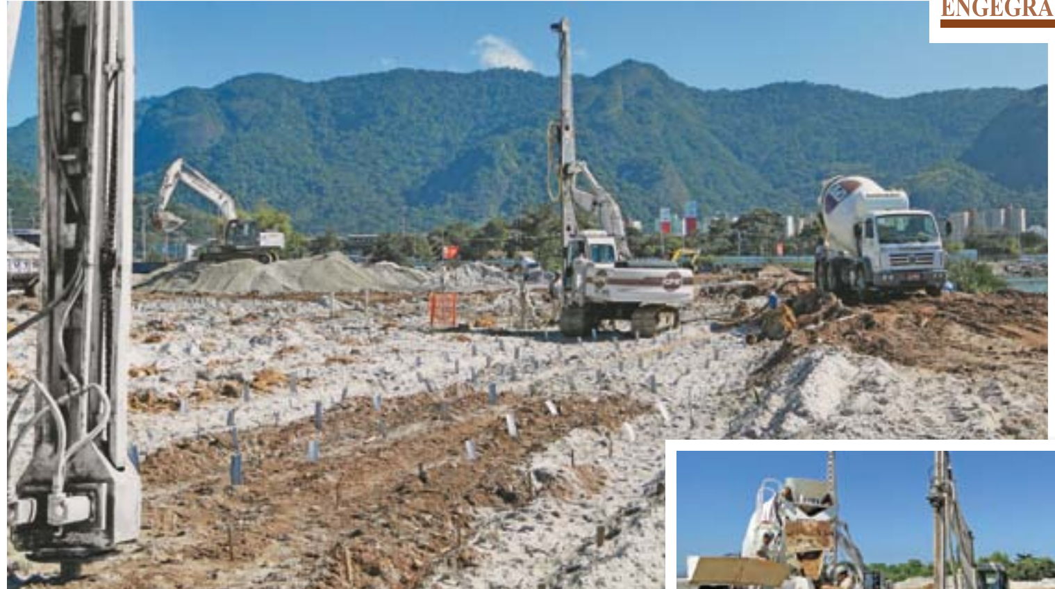
Geodrenos e verticais de enrijecimento do solo de fundação sendo executados, imediatamente seguido pelo aterro.
