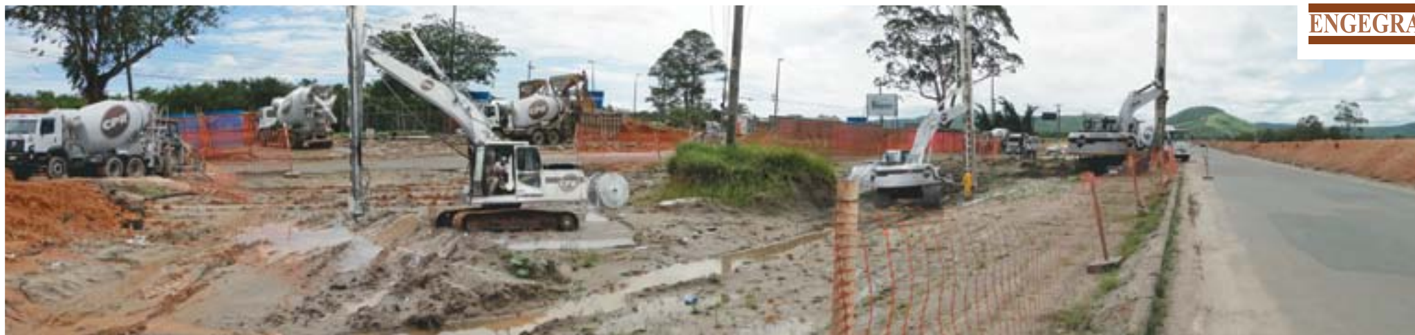
Com a rapidez que a prefeitura desejava, executou-se pré-furos, geodrenos e verticais de enrijecimento em tempo recorde.
