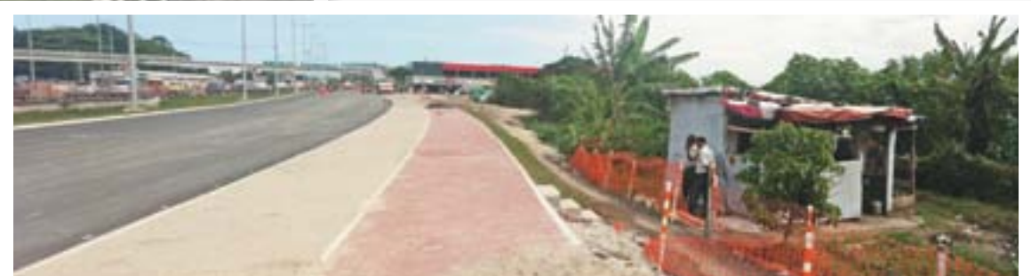
...e a pista já finalizada
