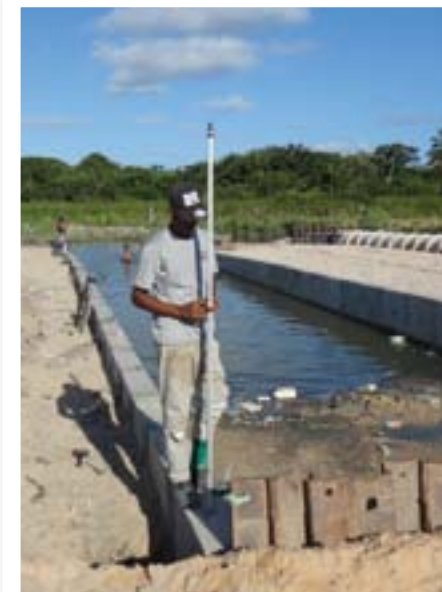
O canal, já assentado, sobre o solo enrijecido com CPR Grouting.
