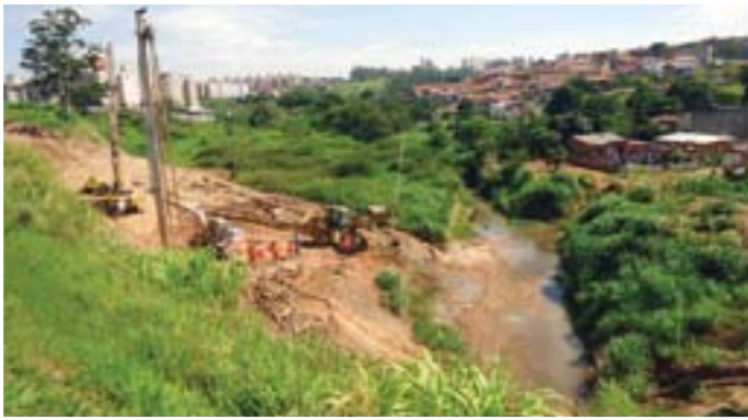
O CPR Grouting sendo executado no trecho 3, que cruza um rio e margeia um gasoduto de 800mm de diâmetro.
