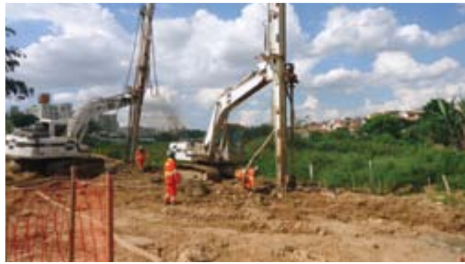
O CPR Grouting foi levado à profundidade de 14m, neste trecho.
