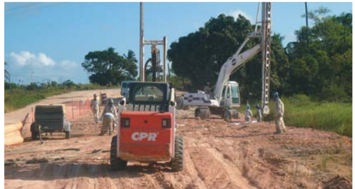
Trechos de aterros com recalques que chegaram a mais de 1 metro, ficando nivelado com a lagoa, recebem préfurros e geodrenos em meia pista.
