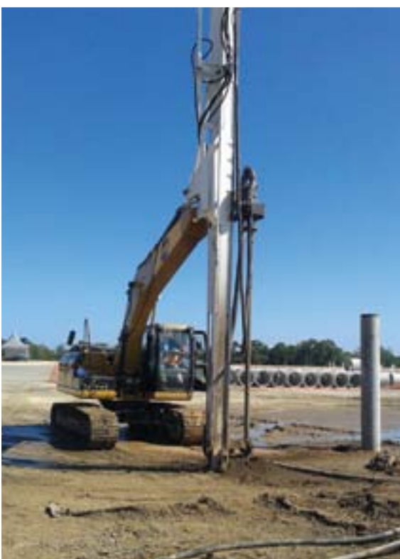
Execução de verticais de enrijecimento ao longo de 20m de profundidade, em um depósito de areias fofas, com monitoramento do nível de resistência e rigidez praticamente simultâneo aos serviços.
