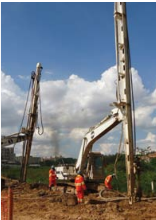
O CPR Grouting sendo executado no trecho 1.
