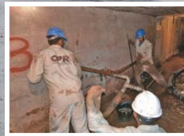
Recalque na rodovia Raposo Tavares, km 546 + 800 em Regente Feijó, SP. Interrupção dos recalques com enrijecimento do solo de fundação, com CPR Grouting, sem interrupção do tráfego. OAS Engenharia e Participações LTDA - Regente Feijó - São Paulo
