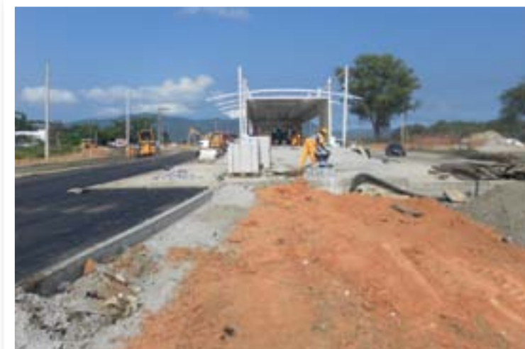
Pistas e a estação BRT já sendo finalizadas.
