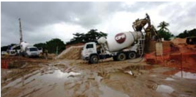
A central do geogROUT nesta obra.
