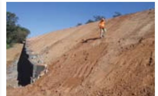
Obra quase entregue no trecho 2, com altura de aterro de 8m.
