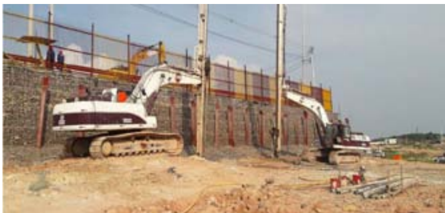
Serviços de CPR Grouting na ampliação da área portuária de Manaus.
