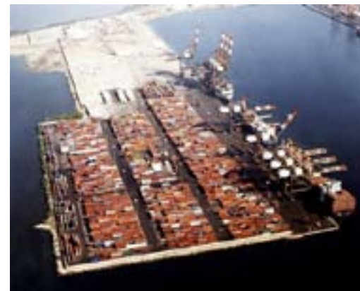
Terminal de contêineres do Porto de Kingston, Jamaica.
