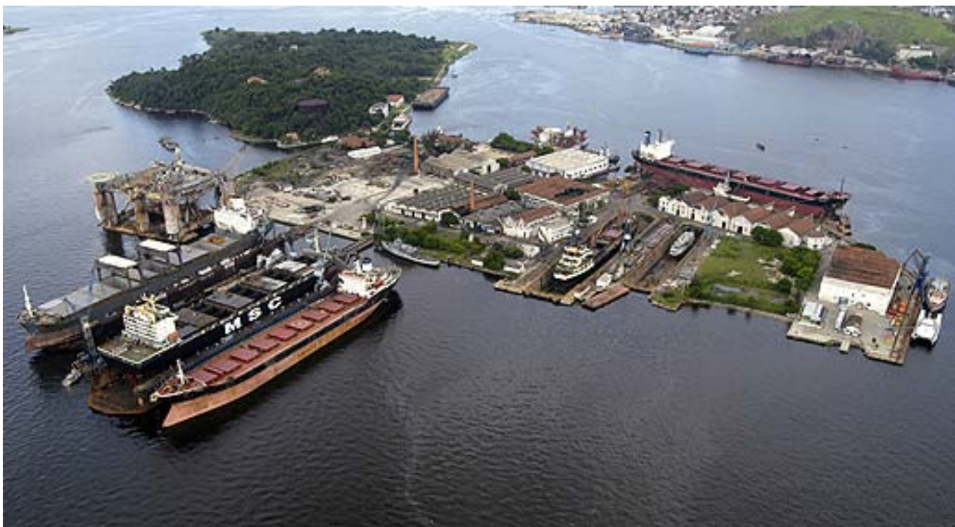
Visão aérea do Estaleiro Renave, situado na Ilha do Viana, RJ.
