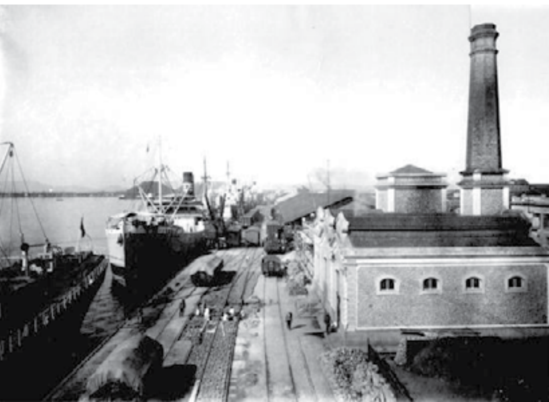
A primeira mostra o porto por volta de 1902, tendo em primeiro plano o primitivo escritório da Companhia Docas e a chaminé da casa de compressores (que permitiam acionar os guindastes hidráulicos do cais)
