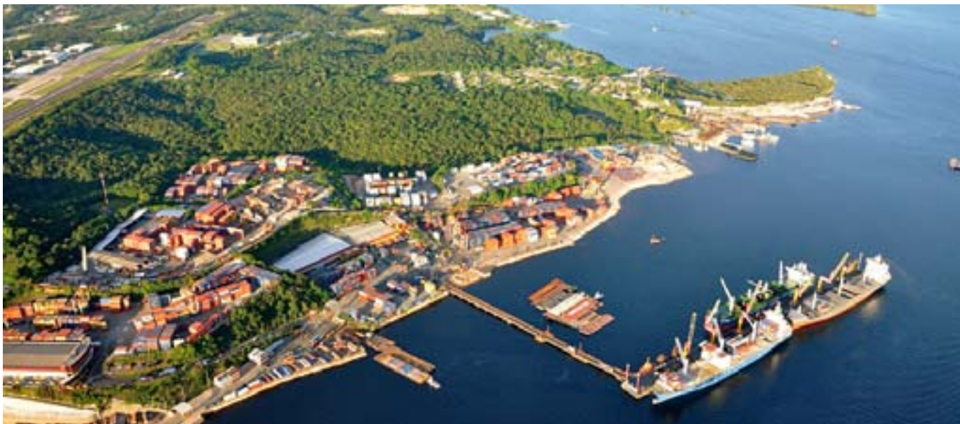
Vista aérea de parte da região portuária de Manaus, onde se processa um volumoso processo de enrijecimento de depósitos de solo mole, a profundidades de 30m, com CPR Grouting, ao longo do Rio Negro. Tanto para efeito de recuperação das áreas degradadas pela tragédia de 2010, quanto para ampliação da zona portuária.
