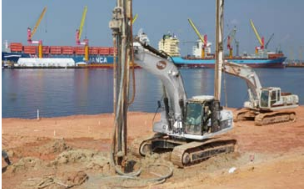
Obras de CPR Grouting, ao longo do Rio Negro, para ampliação da área portuária de Manaus, com infraestrutura tipo sólida.
