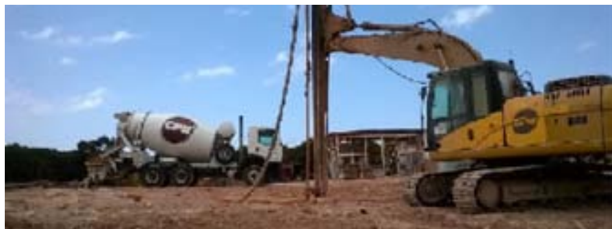
A formação das verticais com bulbos de compressão e enrijecimento do solo mole.
