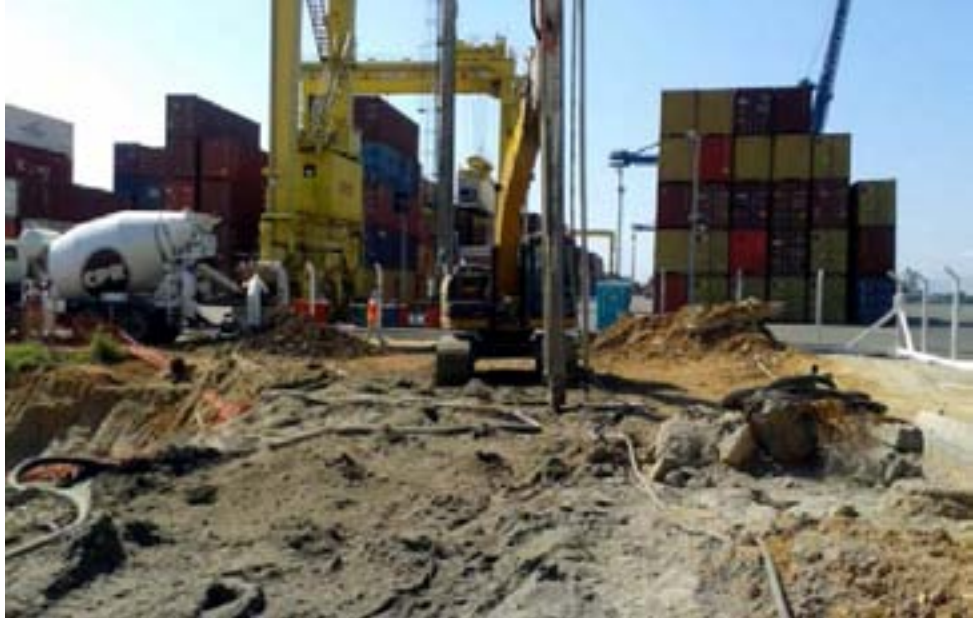
A execução de pré-furos necessários para atingir-se os depósitos de solo mole.
