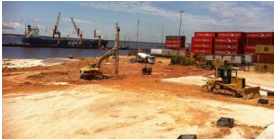
CPR Grouting ampliando a zona portuária.
