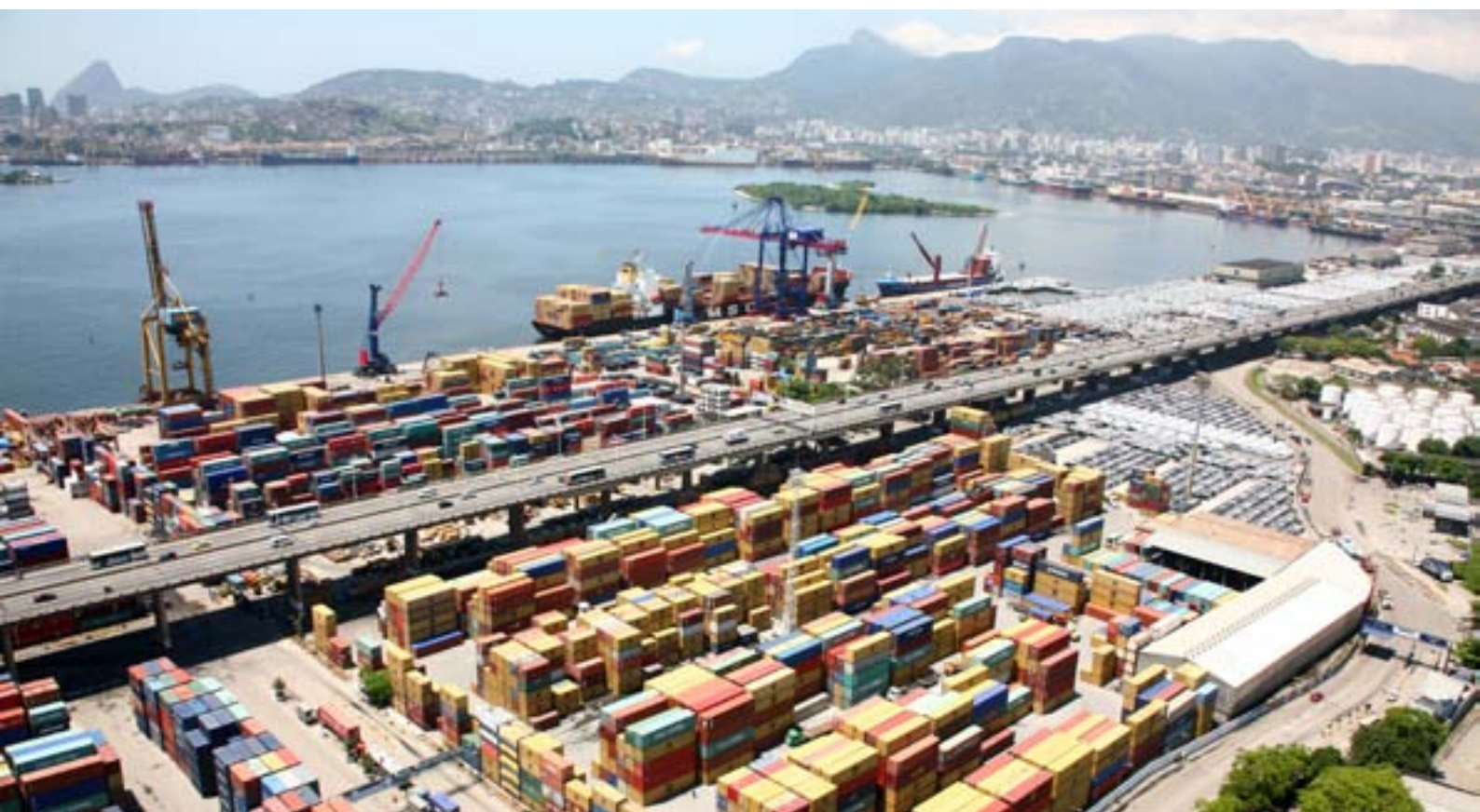
Porto do Rio de Janeiro. Enrijecimento de solo na retroárea.
