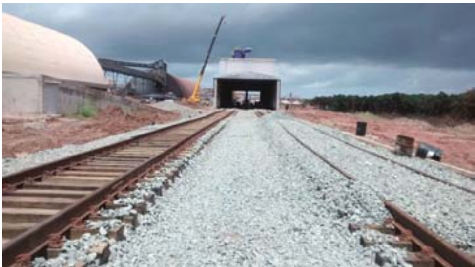
O assentamento das linhas ferroviárias sobre o solo tratado.
