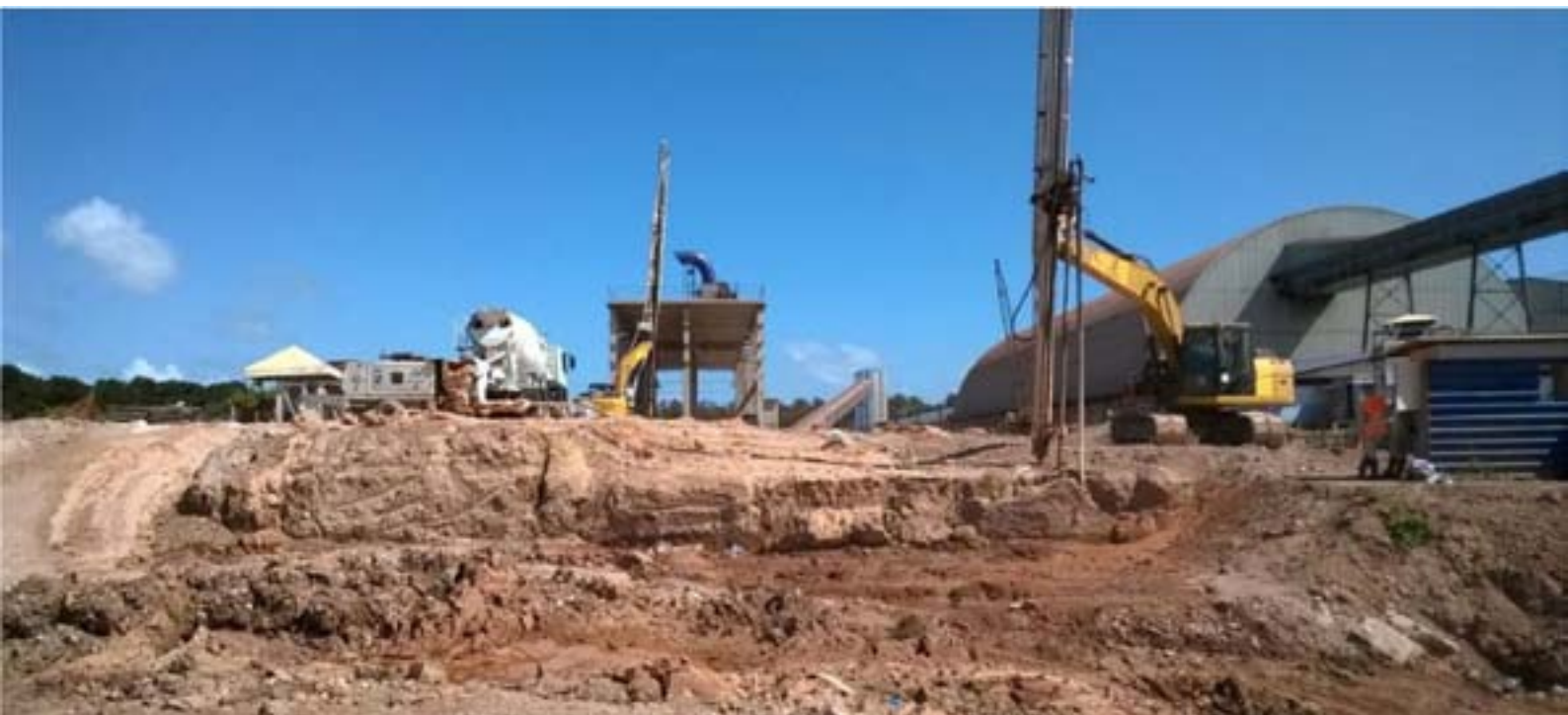
Formação das verticais de bulbos de compressão do solo, com CPR Grouting, no Porto do Itaqui, Maranhão.
