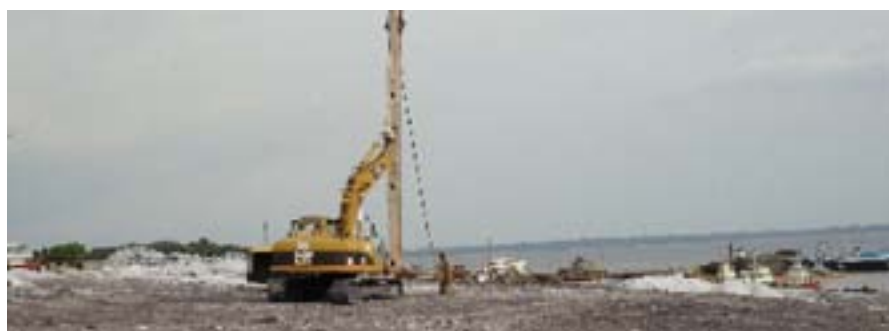
O enrijecimento do solo junto ao cais do porto.
