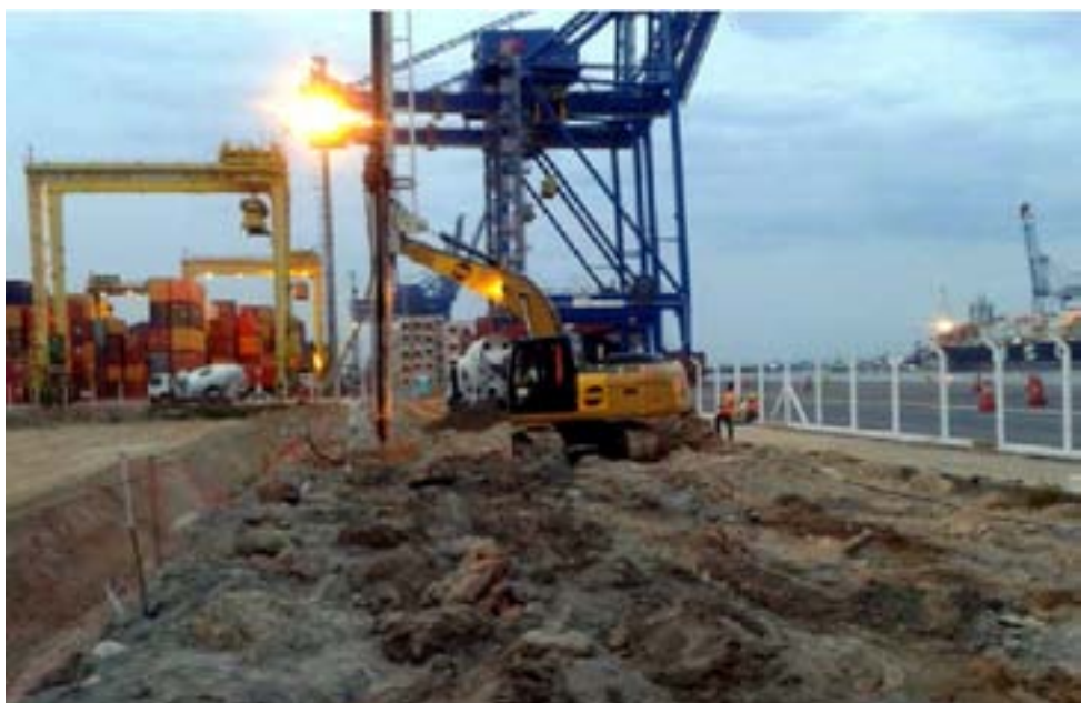
O CPR Grouting ao longo do retroporto.
