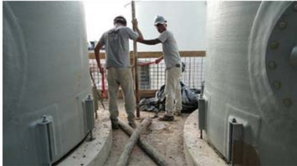
Instalação de inclinômetros para controle de qualidade junto às estacas.
