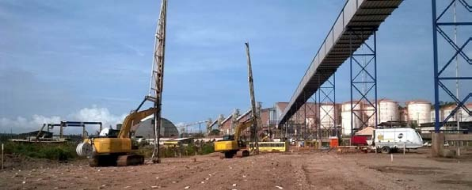
Cravação de geodrenos. Obras de enrijecimento de depósitos de solo argiloso mole sob aterro recém lançado, com CPR Grouting, de modo a viabilizar a construção da ferrovia no Porto do Itaqui, Maranhão.
