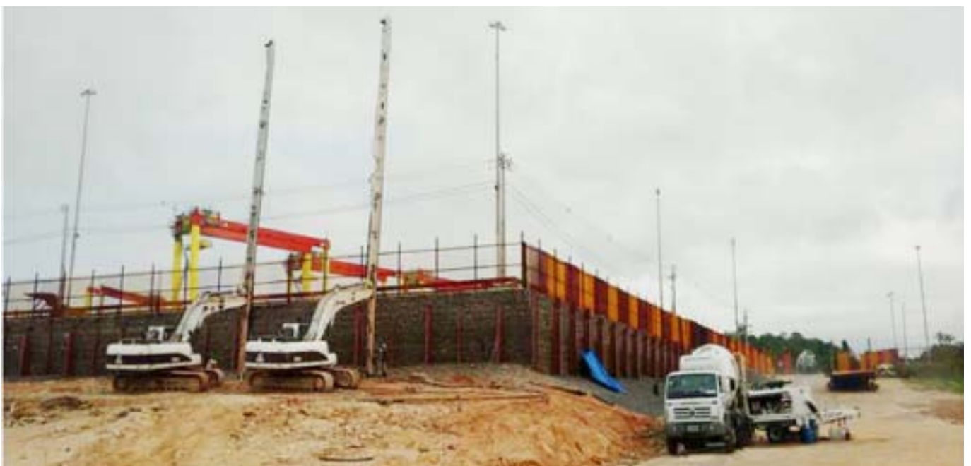
CPR Grouting na retroárea portuária.
