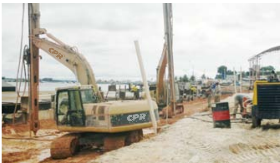
Serviços de CPR Grouting de reforço do solo próximo as áreas afetadas pelas rupturas ocorridas em 2010.
