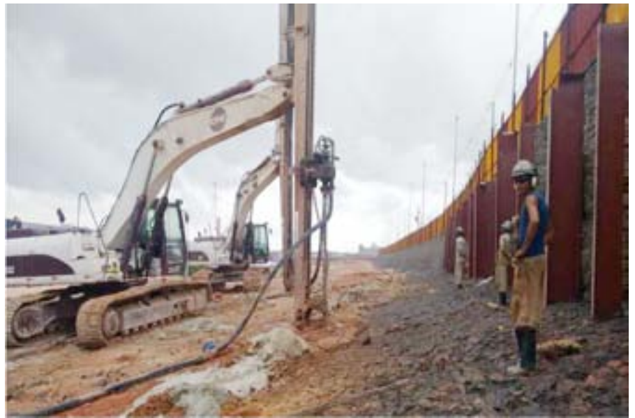
CPR Grouting na ampliação do porto.
