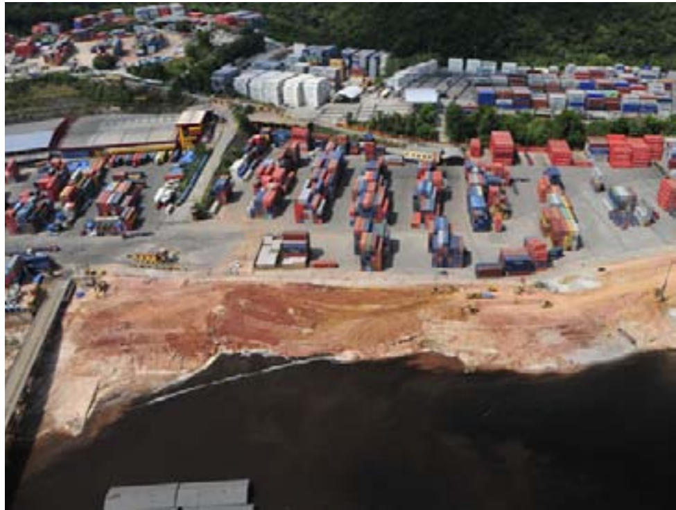
Visão aérea de parte da zona do cais, onde ocorreram as rupturas, sendo enrijecido com CPR Grouting.
