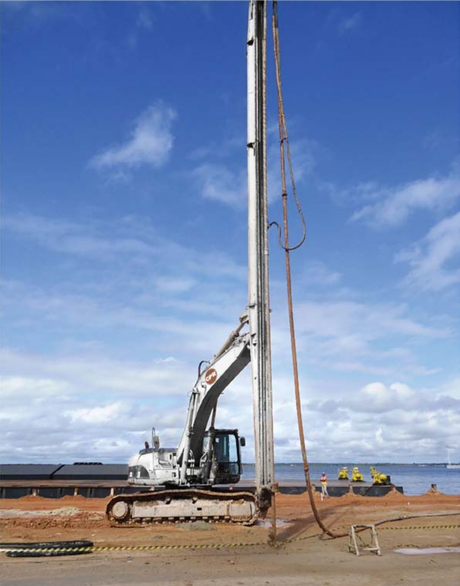
Serviços de enrijecimento do solo ao longo do cais de Manaus, nas zonas não afetadas pelo desastre de 2010.
