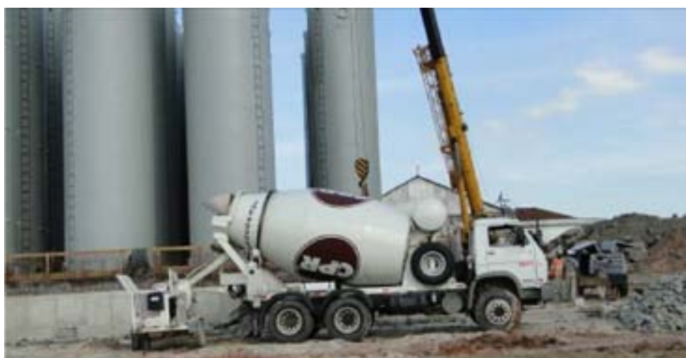
Os trabalhos de CPR Grouting, sendo executados...
