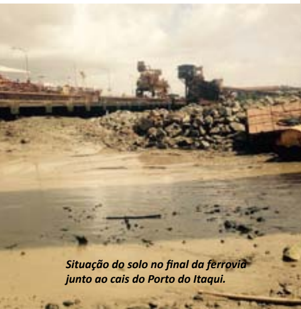
Os depósitos de solo mole, com profundidade de até 15m, estavam sob um aterro com 5m de espessura.
