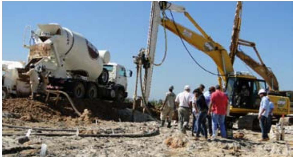
A moderna tecnologia CPR Grouting em área portuária.
