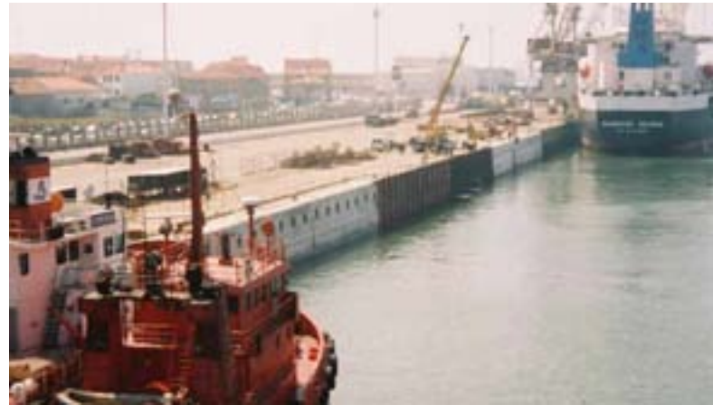
Perfil de infraestrutura portu3ria do tipo s3lida.
