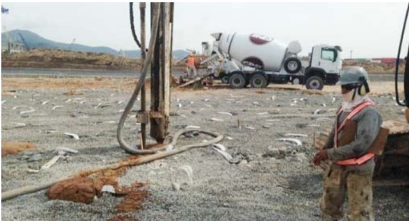
Após a cravação dos geodrenos, a execução das verticais com bulbos de compressão do solo.
